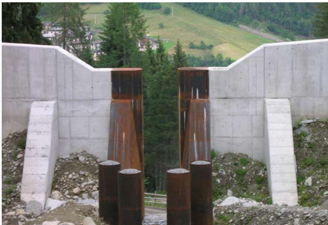
FOTO La briglia aperta in costruzione sul conoide del rio Val del Duc a Daolasa (2006).
