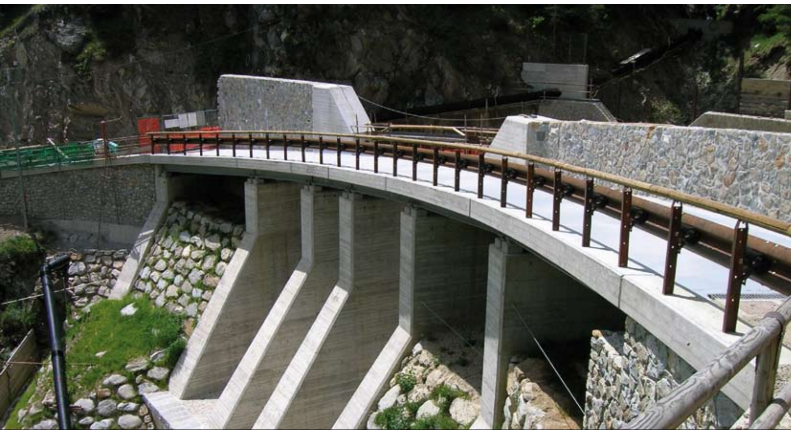
FOTO Il nuovo ponte della strada comunale sulla briglia aperta del rio Cortina a Vermiglio (2006)
