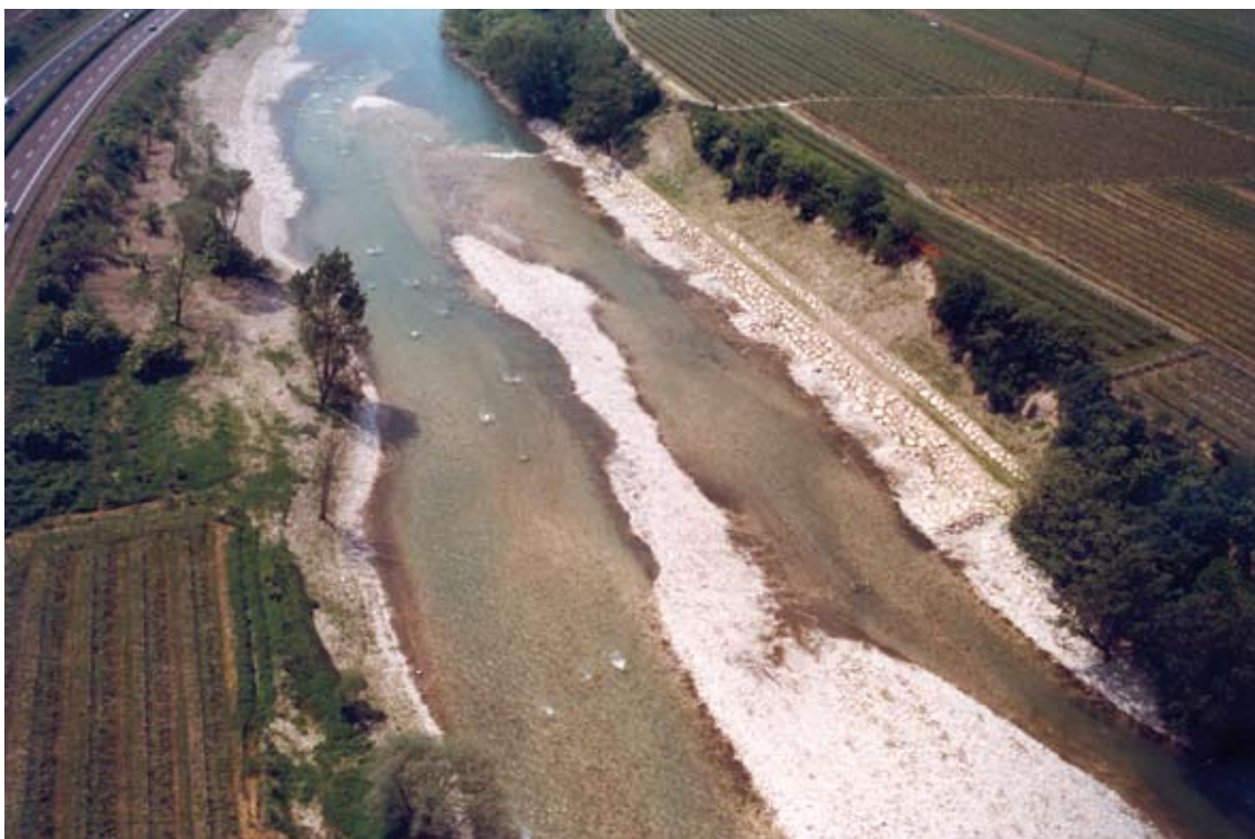
FOTO Intervento sul fiume Adige, nei pressi di Ala (2004)
