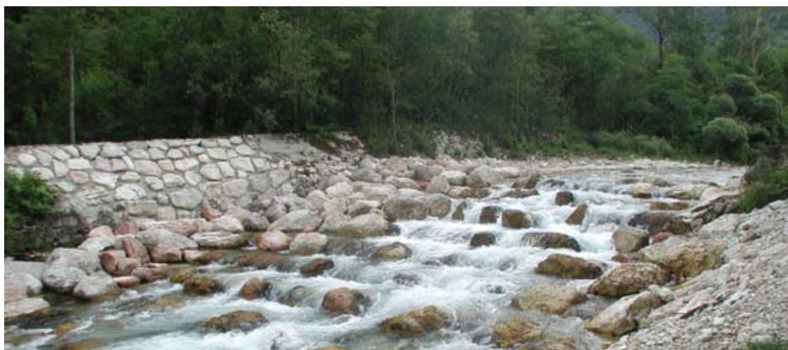
FOTO Manutenzione straordinaria di vecchie opere sul torrente Leno di Terragnolo: sostituzione di una briglia con una rampa in massi
