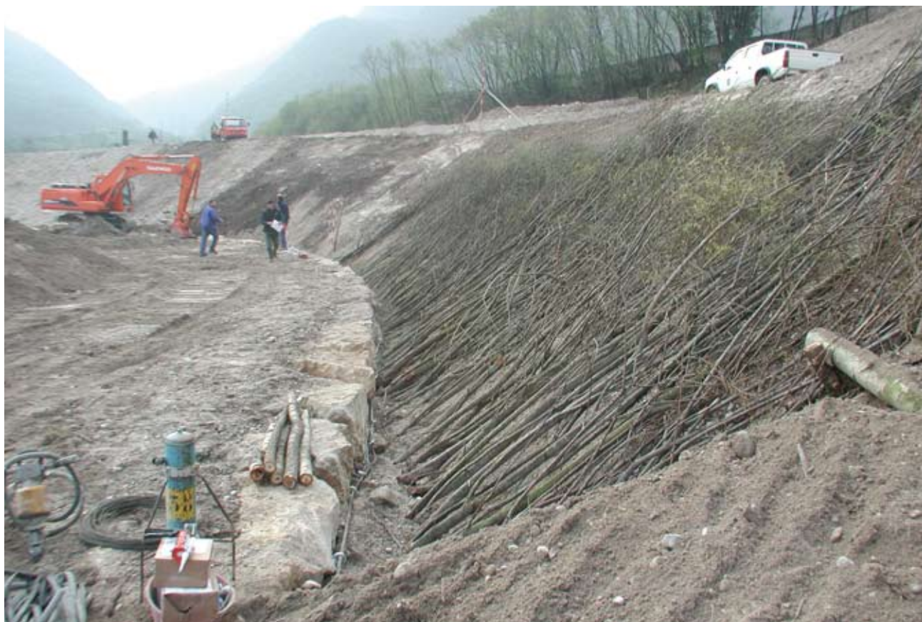
FOTO Realizzazione di difesa spondale mediante copertura diffusa di salici (torrente Cavallo)
