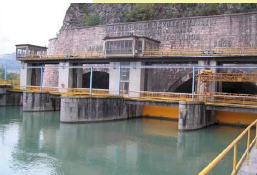
FOTO Gli impianti e le paratoie all'imbocco della Galleria Adige-Garda
