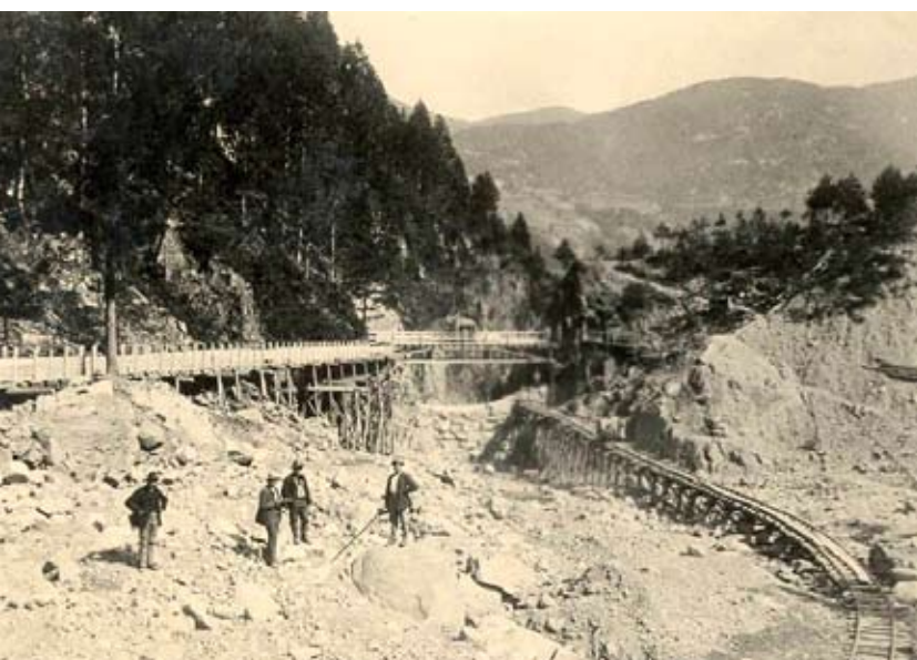
FOTO Rio Brusago: lavori di realizzazione della briglia di trattenuta sul corso inferiore (fine Ottocento)
