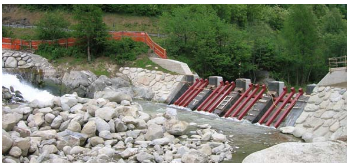
FOTO Briglia aperta con contrafforti in costruzione sul torrente Vermigliana a Fucine (2006)
