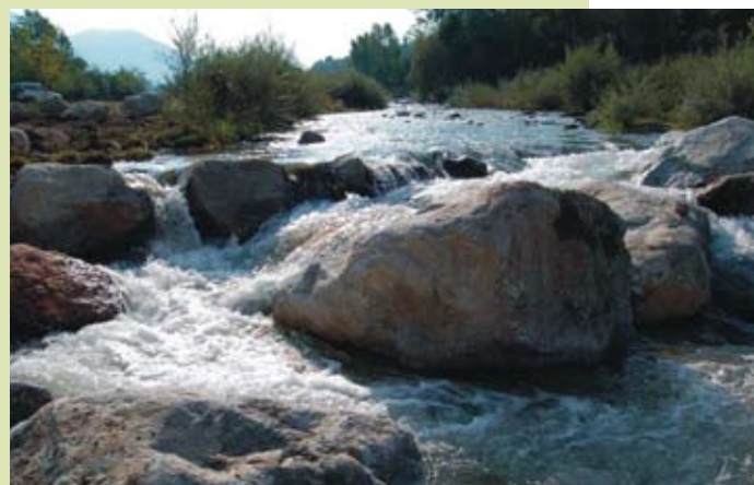
FOTO Opere trasversali e rampa di risalita per garantire la continuità idraulica del corso d'acqua
