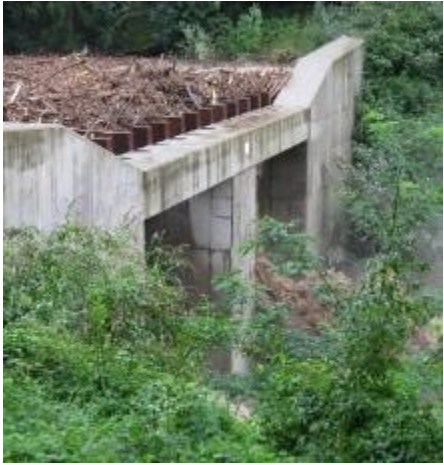
Briglie di trattenuta / Check Dam
