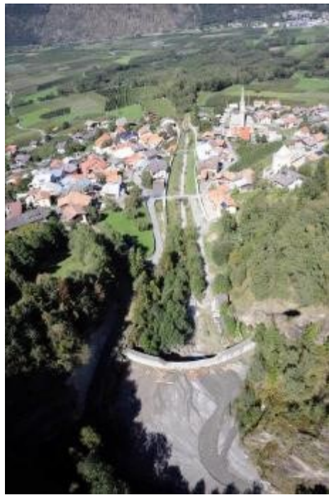
Briglie di trattenuta / Check Dam
