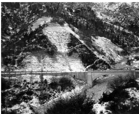
FOTO Sistemazione di versante sul Torrente Centa, al ponte della Fricca, anno 1935
