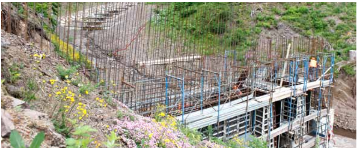
FOTO Costruzione delle opere per il controllo del trasporto solido sul Rio Val Molinara, dopo l'evento alluvionale dell'agosto 2010 nel comune di Baselga di Piné
