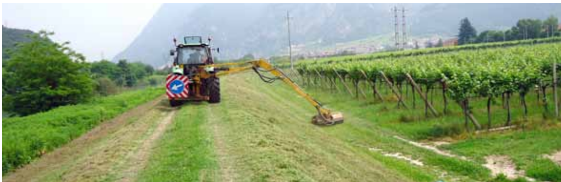
FOTO Manutenzione dei rilevati arginali sul Fiume Adige
