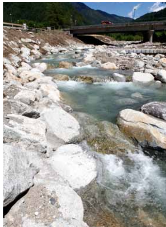
FOTO Passaggio per pesci sul Fiume Sarca in Val Rendena
