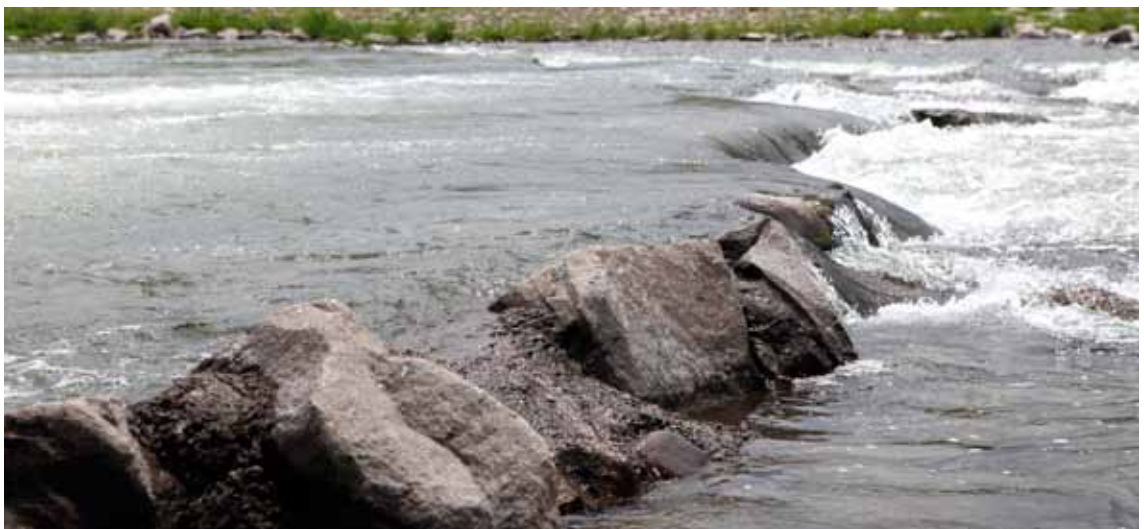
FOTO Soglia in massi e calcestruzzo sul torrente Avisio
