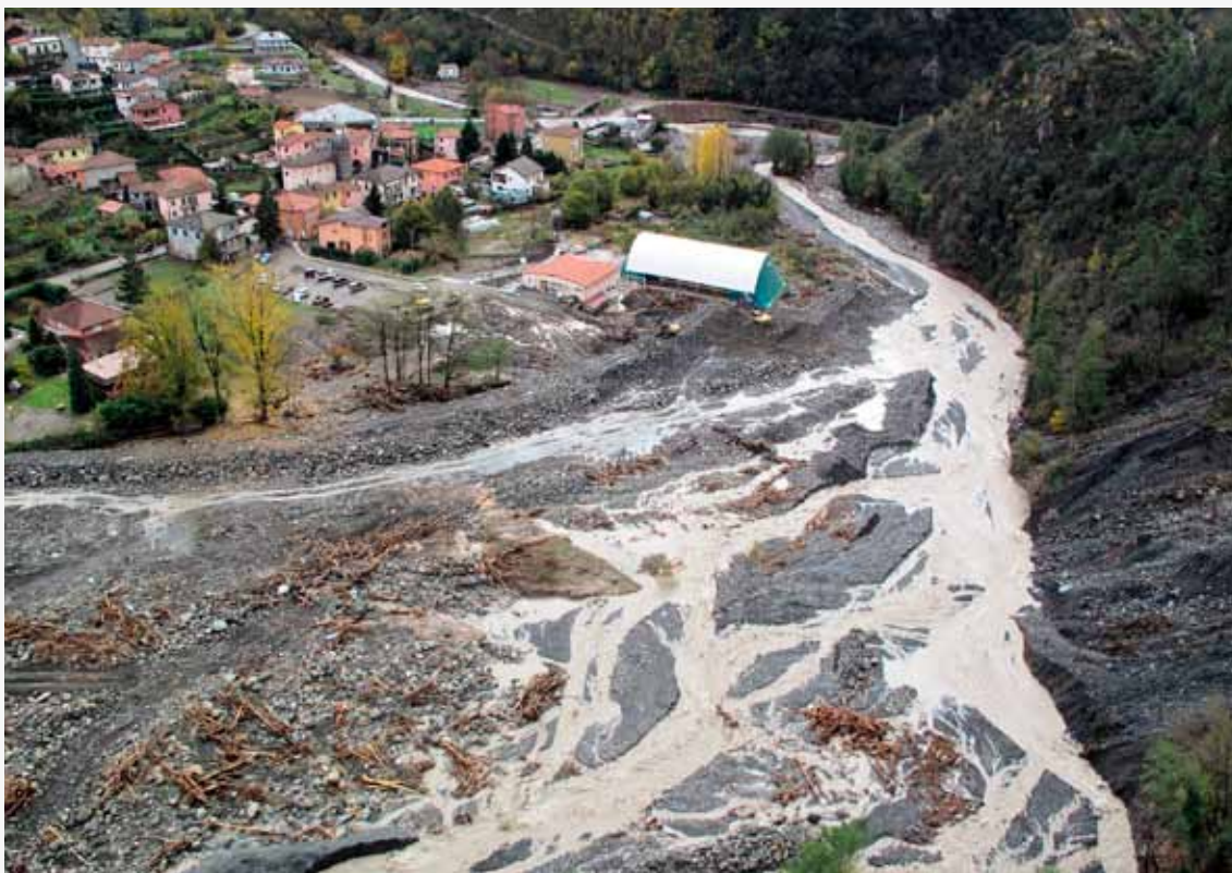
FOTO Nella pagina a fianco: ripresa aerea del ponte abbattuto dalla piena del torrente Gravègnola alle porte di Rocchetta di Vara.
