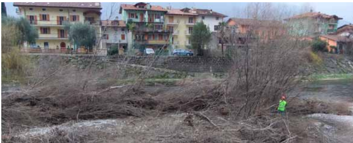
FOTO Taglio della vegetazione in alveo nel fiume Sarca ad Arco, dopo le piene del 2010.
