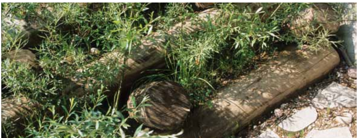
FOTO Consolidamento spondale in legname e pietrame con talle di salice.
