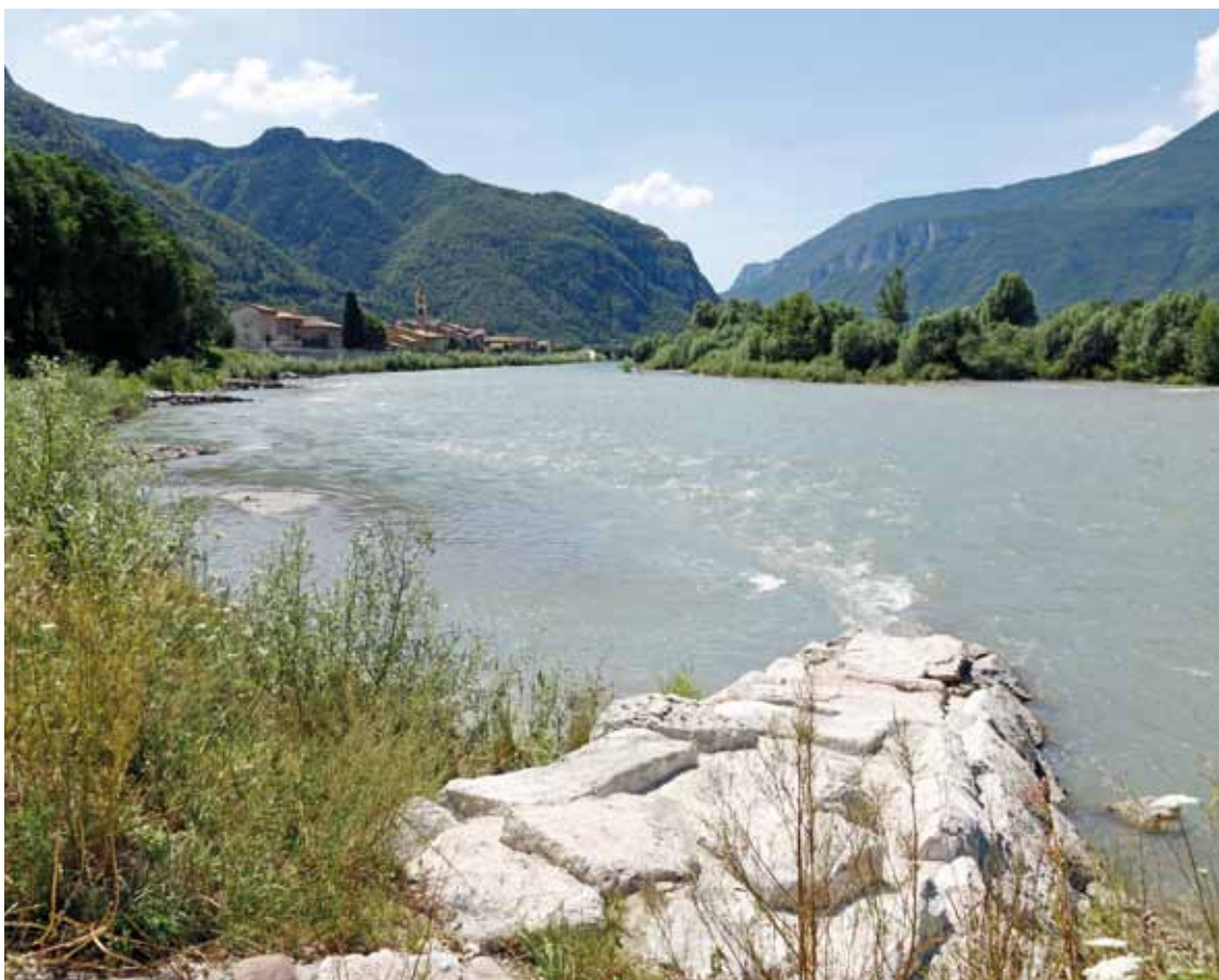
FOTO Difese di sponda e replenti sul fiume Adige a Borghetto di Avio.
