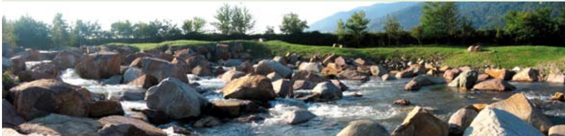
FOTO Vecchia opera trasversale sul torrente Fersina in loc. Frate di Pergine Valsugana.
