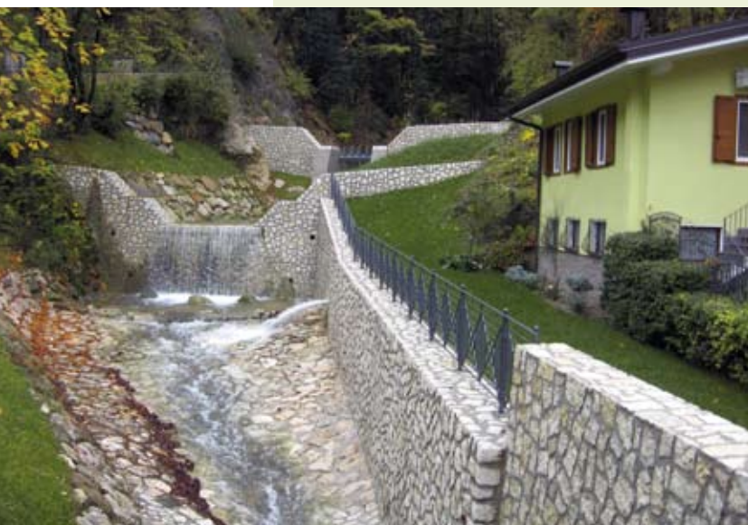
FOTO Briglia filtrante e avanbriglia al termine dei lavori.
