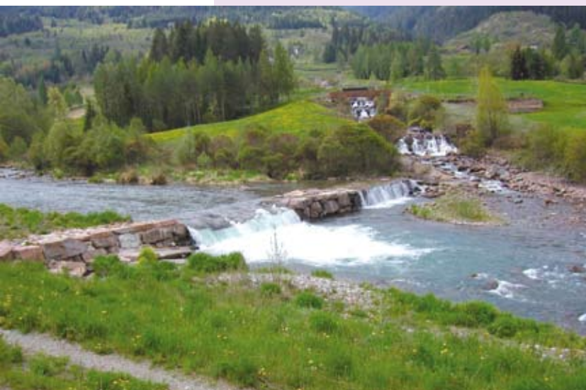
FOTO Vecchia briglia in massi cementati sul torrente Avisio, alla confluenza con il rio Lagorai.
