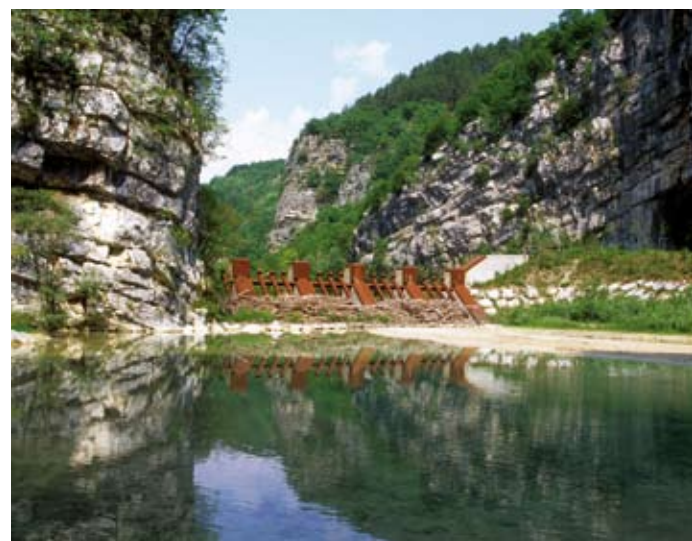
FOTO Briglia aperta (filtrante) sul torrente Leno di Terragnolo.
