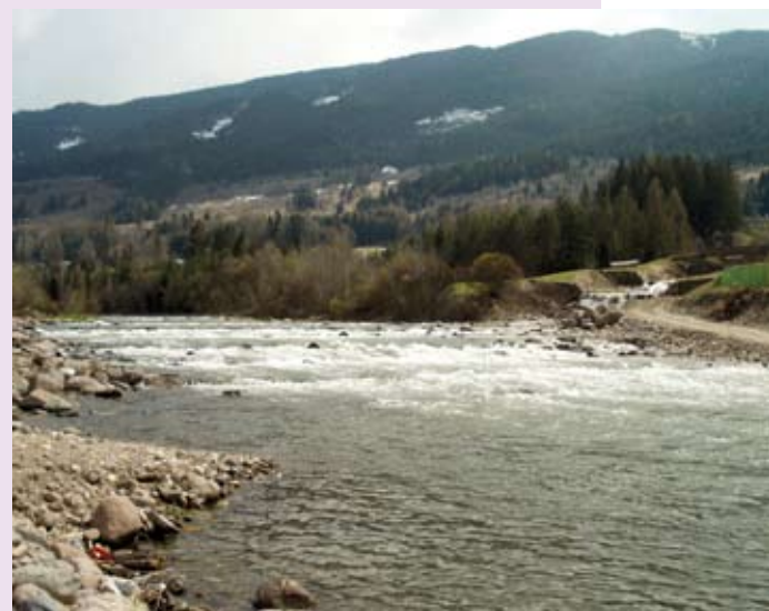
FOTO Dopo l'intervento: è visibile l'effetto step pool creato dalle soglie, che simula una rampa naturale.
