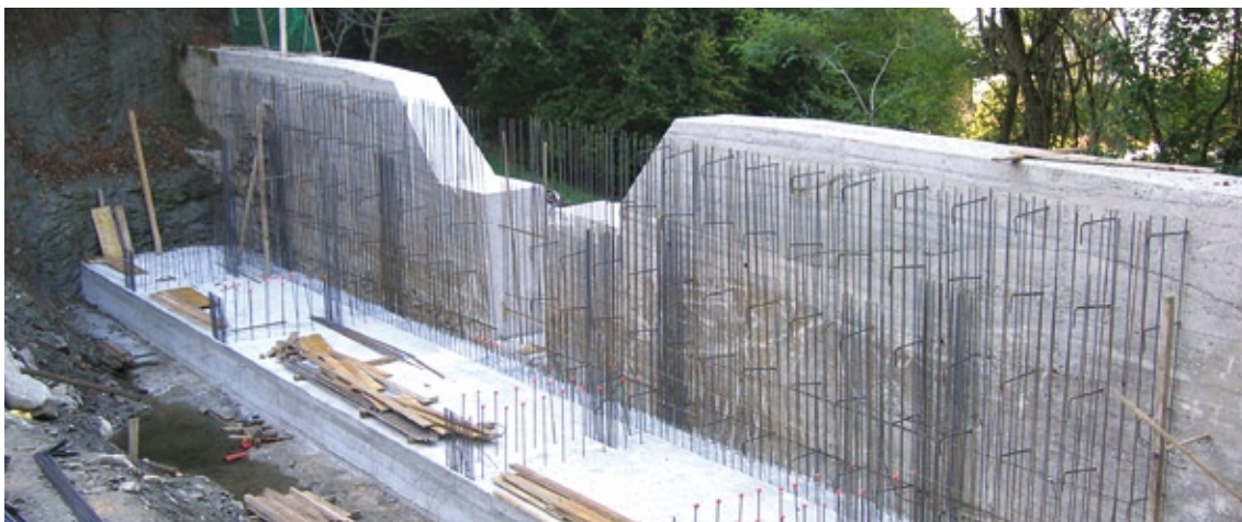
FOTO Briglia in costruzione sul torrente Cinaga, in comune di Samone.
