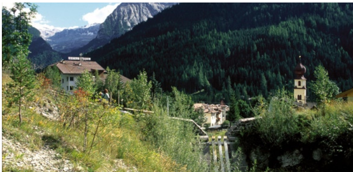
FOTO Briglia filtrante in località Gries di Canazei.
