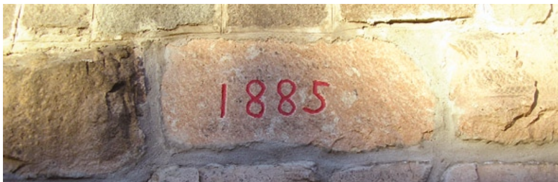
FOTO Particolare del muro d'argine del torrente Travignolo a Predazzo dov'è incisa la data di costruzione.
