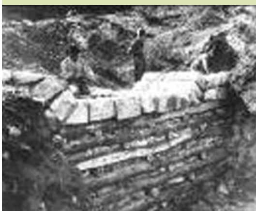
FOTO Costruzione di una briglia in legname e sassi nell'ambito della frana Ai Valletti presso Campi di Riva, bacino del torrente (Albola, 1936)
