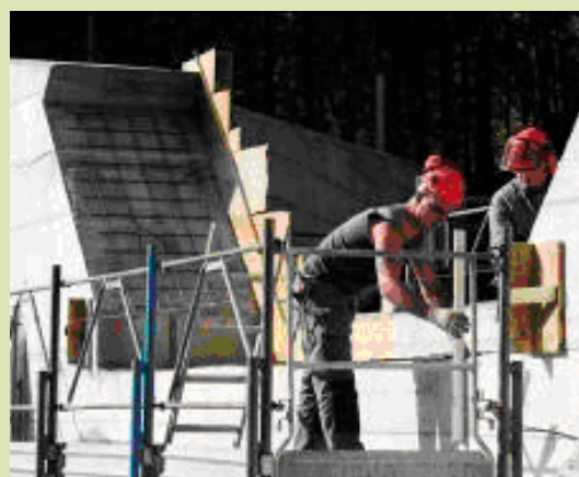
FOTO Operai al lavoro su una briglia in cemento armato (2006)
