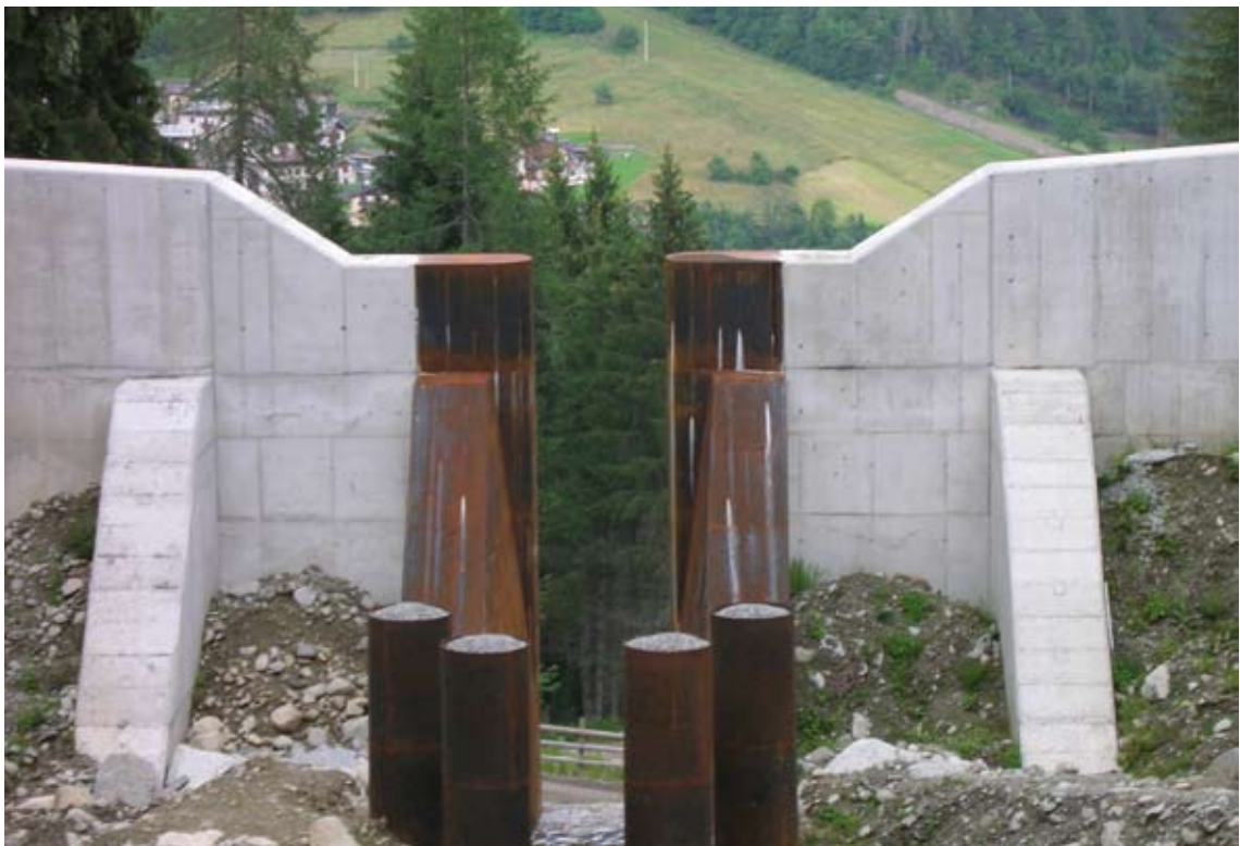
FOTO La briglia aperta in costruzione sul conoide del rio Val del Duc a Daolasa (2006).
