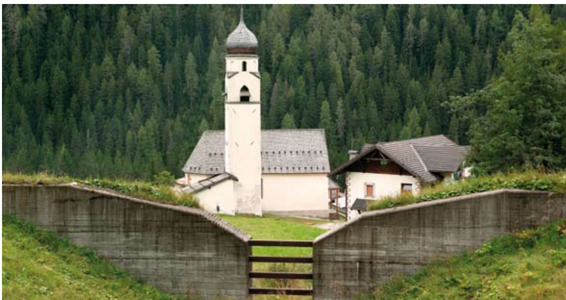
FOTO Briglia aperta sul Rio Doleda in Val di Fassa (1991)
