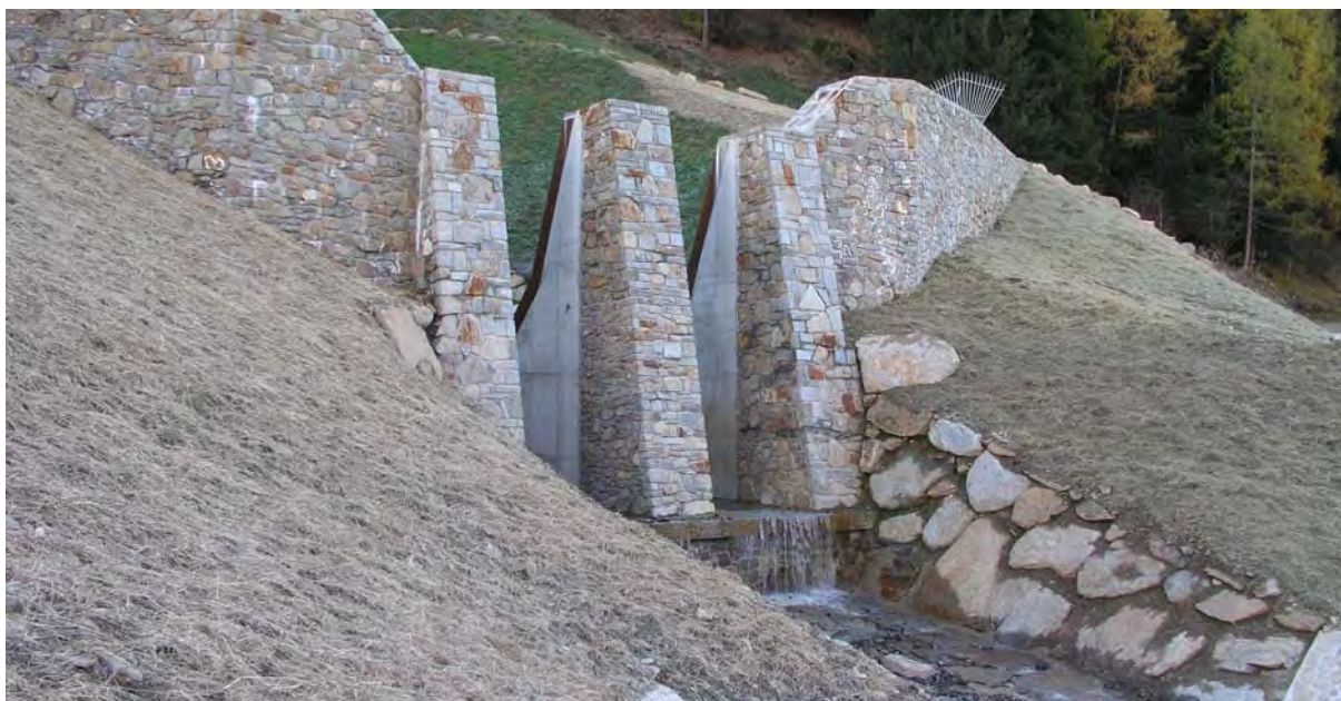
Rio Spini a Celledizzo, Peio: briglia filtrante e sistemazione delle scarpate con tecniche di bioingegneria
